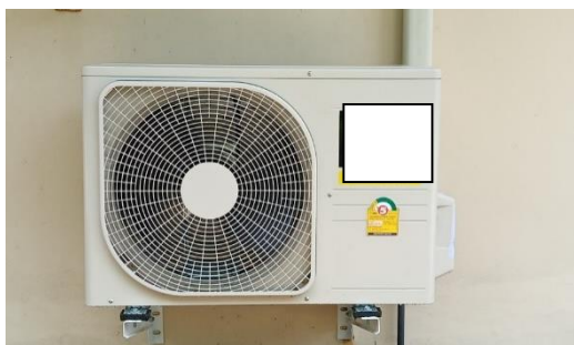
ภาพที่ 1.1 อุปกรณ์ควบแน่น (Condenser) หรือ คอยล์ร้อน (Condensing Unit ; CDU)
