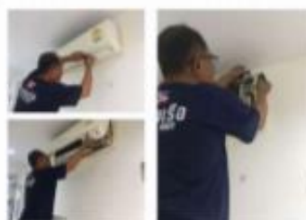
รูปที่ 3 การติดตั้งอุปกรณ์เครื่องวัด
