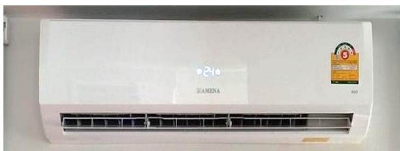
ภาพที่ 2.5 เครื่องปรับอากาศแบบติดผนัง (Wall type)
