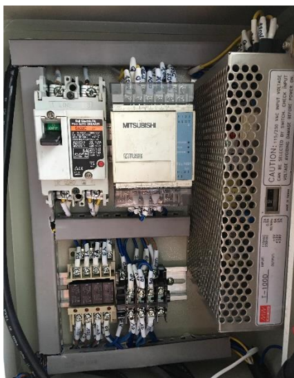
ภาพที่ 3.4 การติดตั้งอุปกรณ์ภายในตู้ควบคุม
