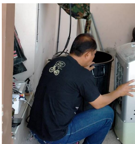
ภาพที่ 3.18 การติดตั้งอุปกรณ์บริเวณถังเก็บน้ำ
