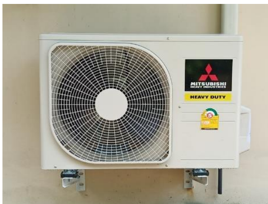
ภาพที่ 3.6 คอยล์ร้อน เครื่องปรับอากาศ ขนาด 20,397 BTU.
