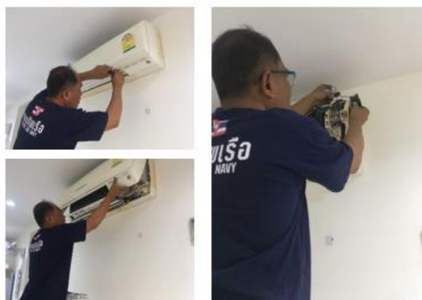
ภาพที่ 3.22 ติดตั้งเครื่องมือวัดบริเวณคอยล์เย็น
