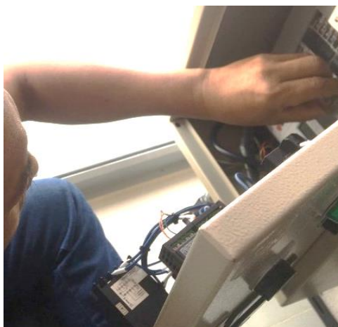
ภาพที่ 3.17 การติดตั้งอุปกรณ์ภายในตู้คอนโทรล
