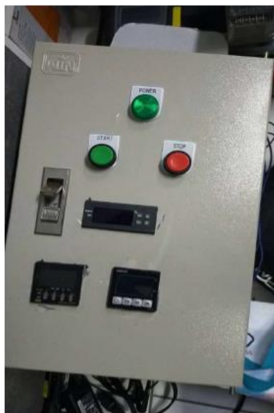
ภาพที่ 3.8 การติดตั้งอุปกรณ์ภายนอกตู้ควบคุม
