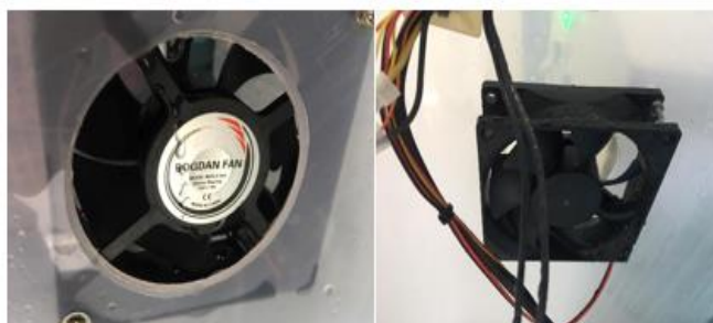
ภาพที่ 3.3 ติดตั้งพัดลมสำหรับดูดอากาศ และระบายอากาศ
