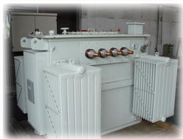
ภาพที่ 2.19 หม้อแปลงชนิดจุ่มน้ำมันแบบปิดผนึก และบรรจุไนโตรเจน
