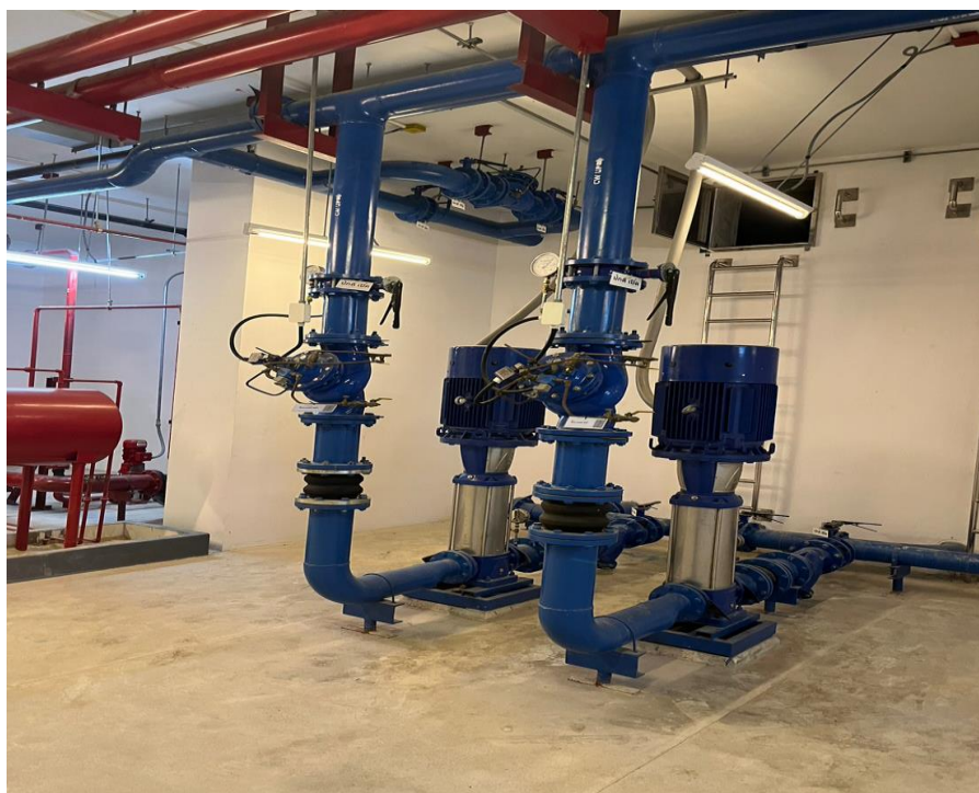
ภาพที่ 4.8 Transfer pump
