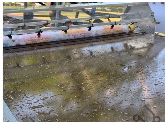
รูปที่ 17 ผลการล้างแผงโซลาร์เซลล์ด้วยระบบอัตโนมัติ Step 2 ล้างคราบปานกลาง
